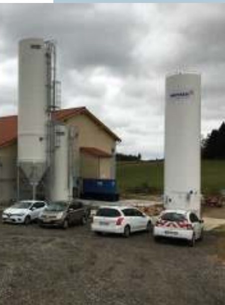
Nouvelle usine avec les silos des produits de traitement (chaux, charbons actif et gaz carbonique)
